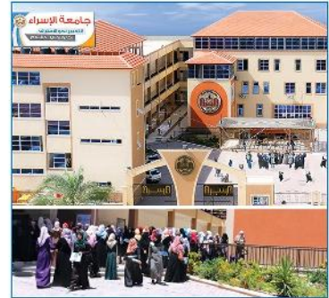
مقر شمال مدينة غزة شارع يافا - المحطة
